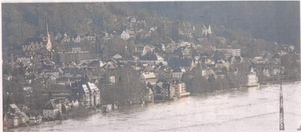
Ein Blick auf die Stadt Linz, deren Uferbereiche durch das Rheinhochwasser überflutet sind. Die Fähre kann voraussichtlich erst frühestens Dienstag wieder verkehren.
